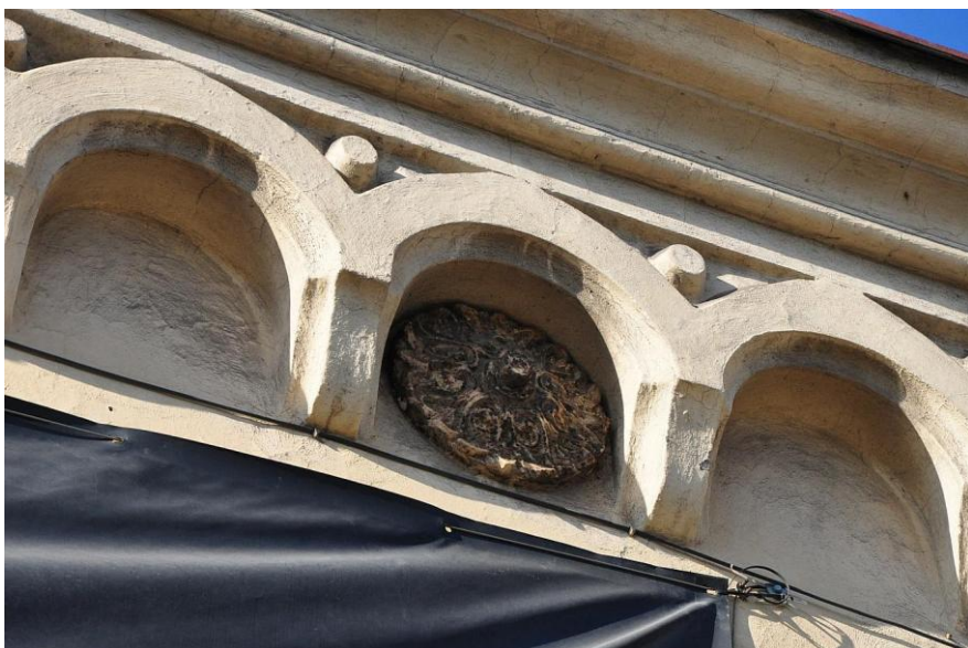
58. Jižní průčelí – sekce 3, ozdobná kotva kleštiny v podřímí.
