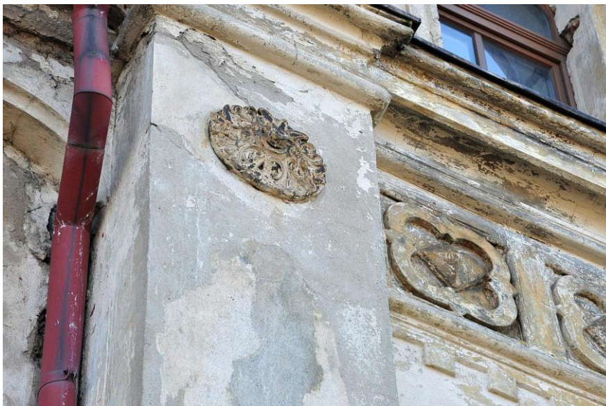
367. Severní průčelí – sekce 5 (hlavní budova), levý rizalit – detail římsy a závlače kleštiny.
