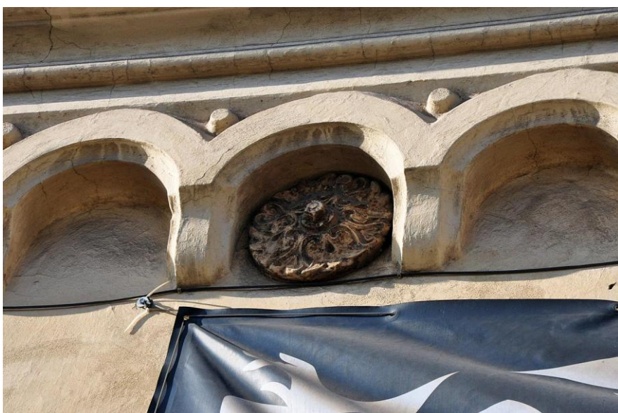
57. Jižní průčelí – sekce 3, ozdobná kotva kleštiny v podřímí.
