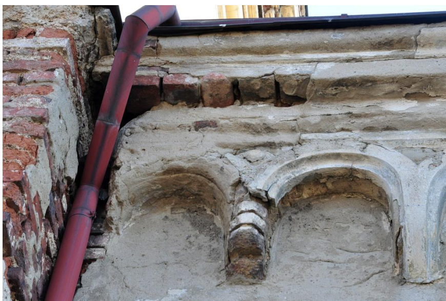
434. Severní průčelí – sekce 4, 1. patro, detail římsy a podřímky.
